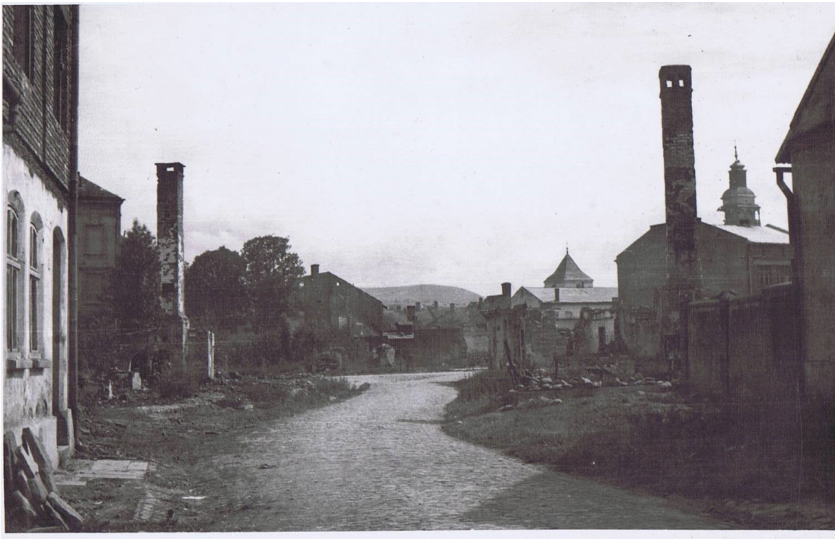
Fot. Zniszczenia zabudowań na Rudzy.
