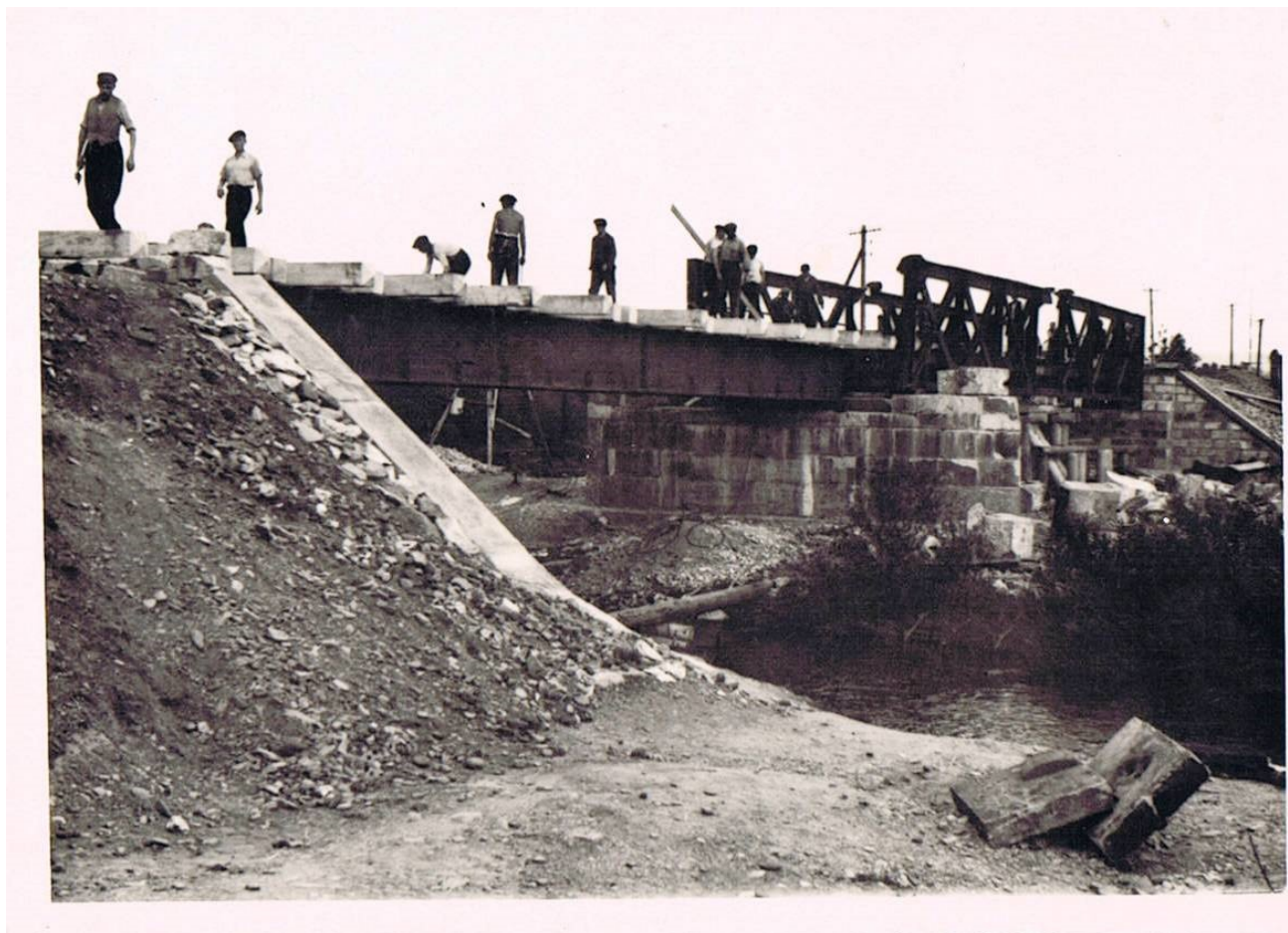
Fot. Odbudowa zniszczeń wojennych w Żywcu.
