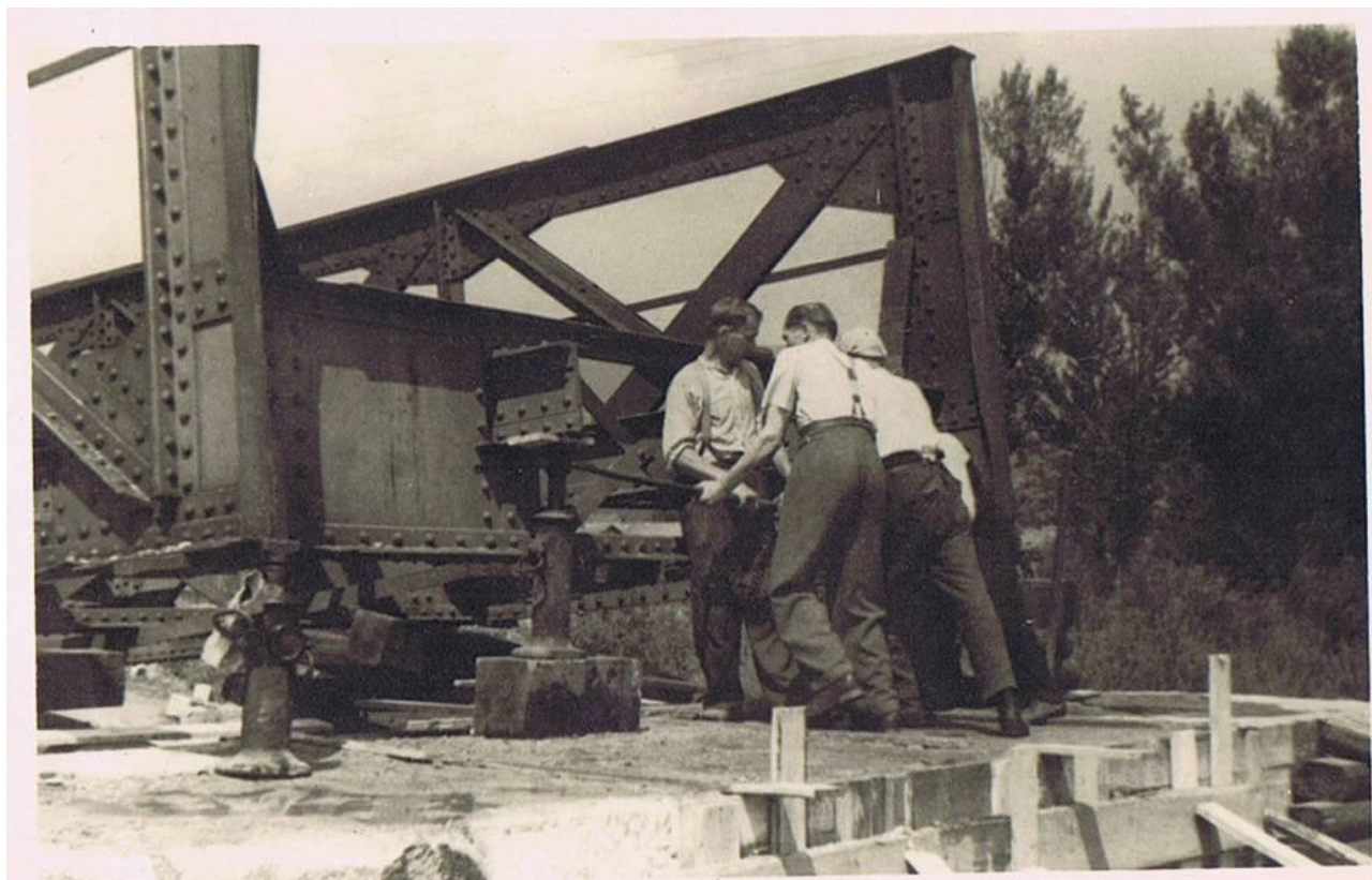
Fot. Odbudowa zniszczeń wojennych w Żywcu
